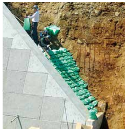
擁壁裏の土砂流出防止
