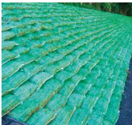
土留グリーンバッグ工
