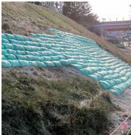
法面崩壊部分の埋戻し
